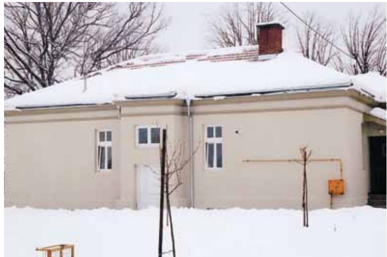
Реконструкција у Врњцима, 2019.
